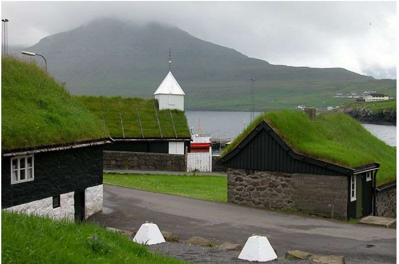
Fig.1: Construções tradicionais com telhados verdes nas Ilhas Faroee, Dinamarca. (foto: Erik Christensen)
